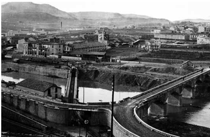
L'estació del Carrilet de Manresa a Berga connectava amb l'estació de tren de la línia Lleida-Barcelona (l'actual estació manresana de la RENFE), a partir d'un pont de ferro construït per la Maquinista Terrestre y Marítima i per permetia creuar el riu Cardener. Fotografia 1909. (ARXIU ARB)
